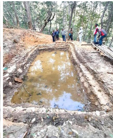
चित्र: ३.३ वन्यजन्तुलाई कुवा निर्माण
